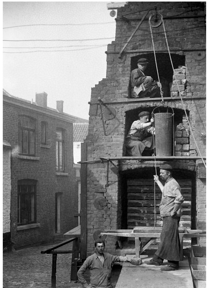
Afb. 4. Het vullen van de oven bij Wingender.
